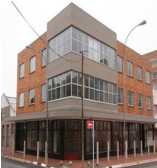
Chancellor House na die restourasie
